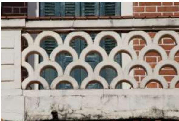
Figura 7. Guarda-Corpo da Fachada do Museu Casa Memória Italiana.
