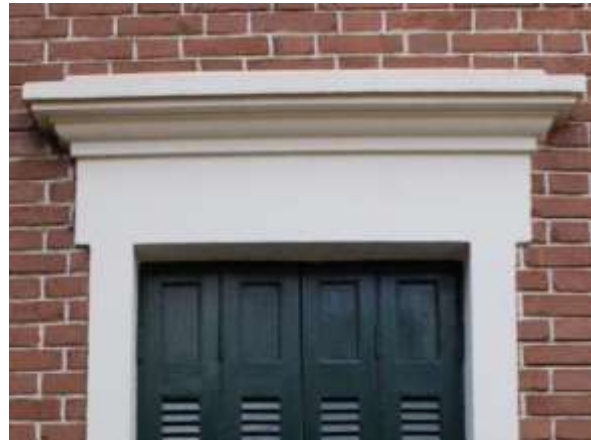
Figura 12. Elemento Sobreverga da Fachada Lateral da Garagem do Museu Casa Memória Italiana.
