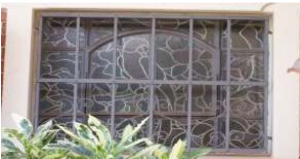
Figura 18. Janela da Fachada Lateral do Escritório do Museu Casa Memória Italiana
