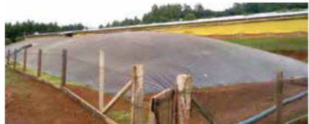
Figura 2. Biodigestor modelo Canadense.
